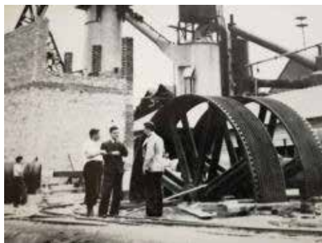
Sl. 1. Izgradnja Talionice Caprag tijekom 1938. godine, (ing. M. Tomac u sredini fotografije)
