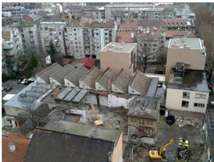
Sl. 15. Rušenje zgrade bivšeg 'Tekstilstroja', odnosno tvornice „Braća Ševčik“ 11. siječnja 2014. godine. Izvor: Zagrebačka industrijska baština / Facebook: https://www.facebook.com/ZagrebačkaIndustrijskaBaština/photos/pcb.618911314842778/618905128176730 ). Snimila: Ana Đorđević
