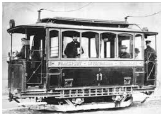
Sl. 33. Tramvaj u Lichterfeldeu, Berlin, opremljen za napajanje iz gornjeg voda
