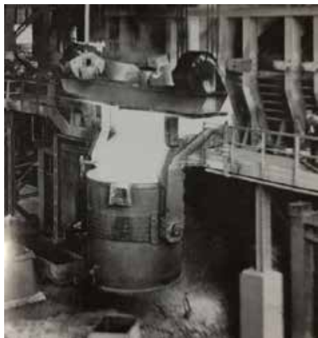
Sl. 6. Lijevanje čelika u lonac iz Siemens-Martinove peći u Željezari Sisak
