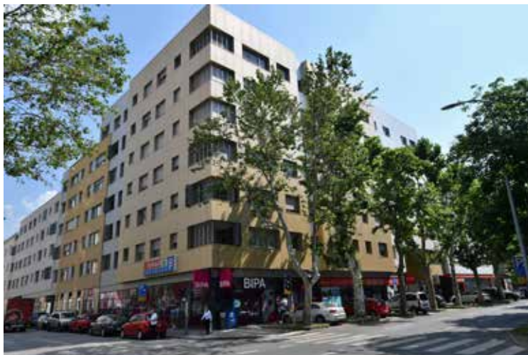
Sl. 18. Stambeno-poslovni objekt na križanju Grahorove i Ulice grada Mainza. Snimio: B. Jagačić, lipanj 2021.
